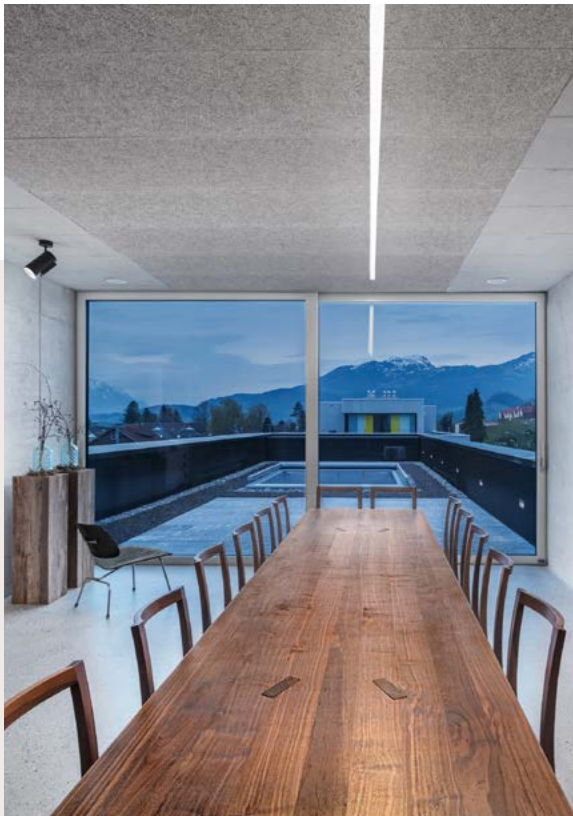
Concept d'éclairage de salle commune: ligne lumineuse encastrée
